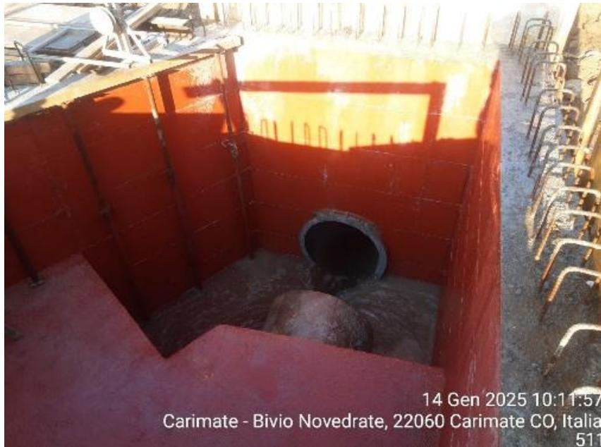
**Figura 10. Cameretta di monte di raccordo con tubazione esistente (fase di taglio con filo diamantato)**
